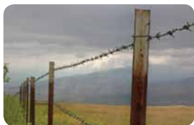
Figura 20.2 – Delimitação de perímetro com arame farpado.
