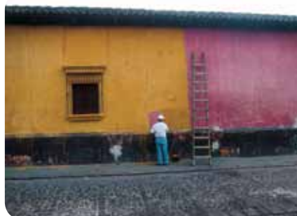
Figura 20.1 – Casa sendo pintada.
